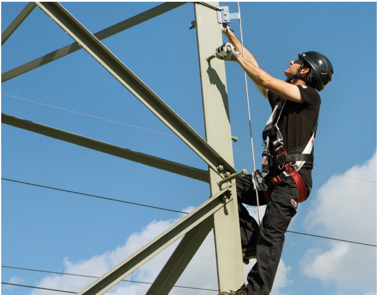
Fangeinrichtung SSE 02 knapp unterhalb der Seilführung
